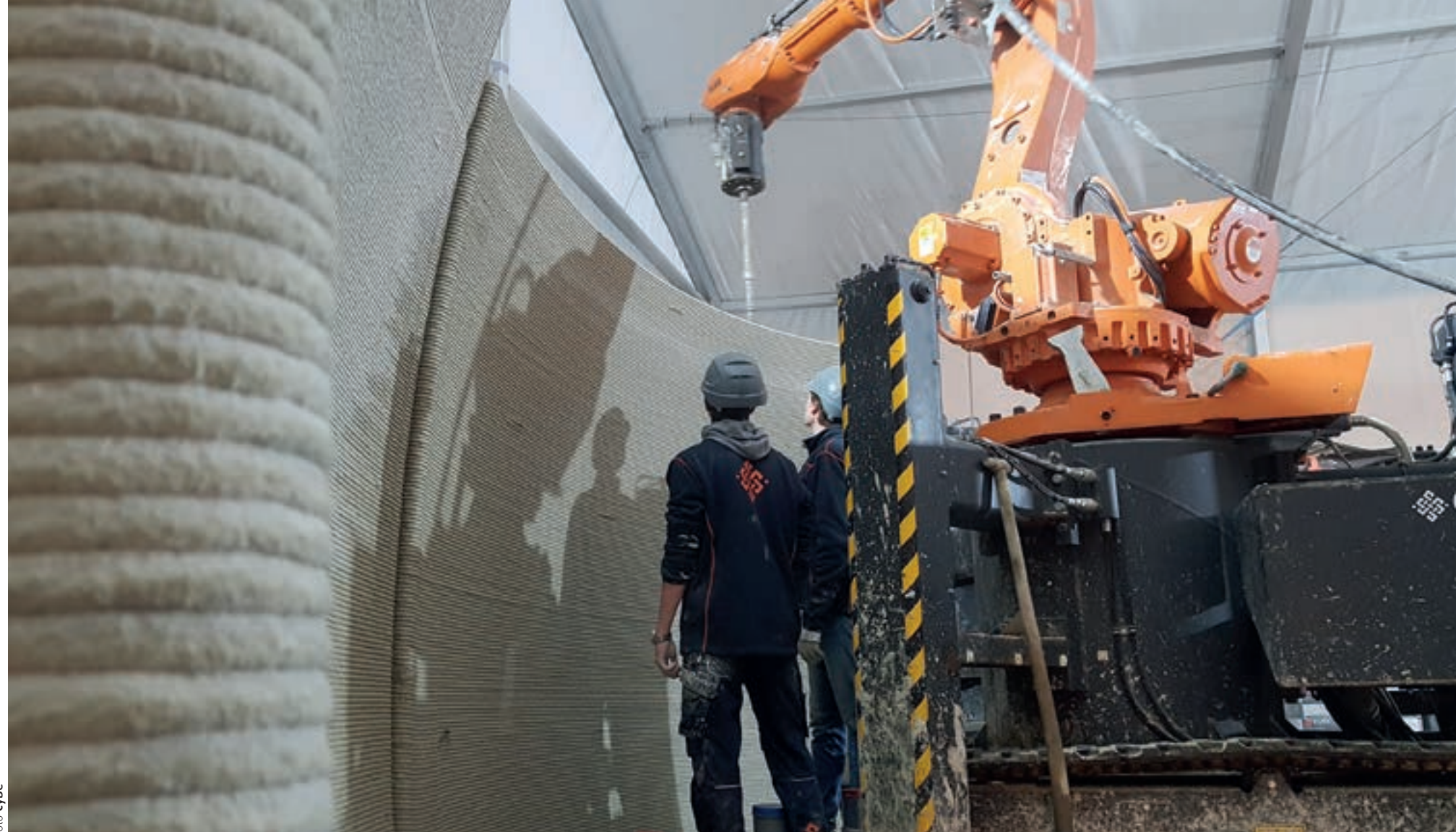
De 3D-betonprinter van het Nederlandse bedrijf CyBe aan het werk. '3D-printen met beton is net Formule 1', aldus Berry Hendriks, oprichter en CEO van CyBe.
