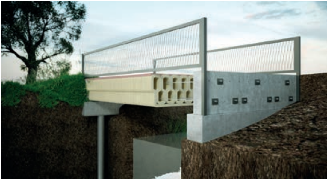
Deze fietsbrug was in 2017 de eerste ge-3D-geprinte betonconstructie die ook flink kan worden belast.
